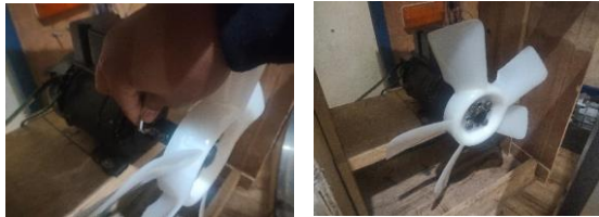
Gambar 9. Pemasangan Adaptor Sudu Ke Mesin Listrik
