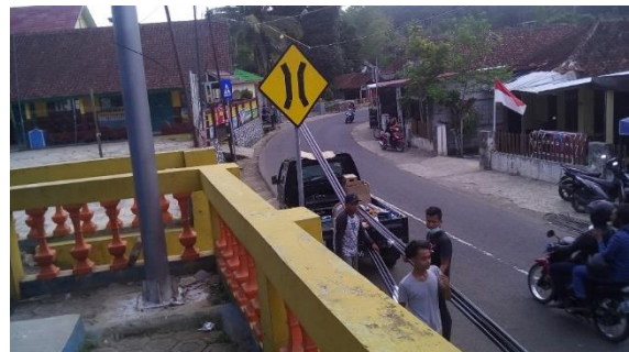
Gambar 8. Pemasangan Kabel pada Tiang
